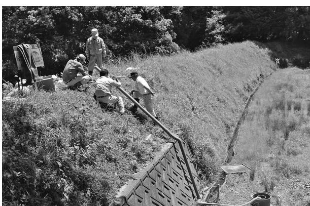
写真14 自動給水システムを設置する工事の模様。
