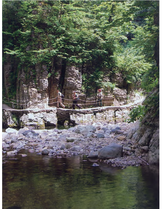
写真8 溪谷に架けられた散策道
