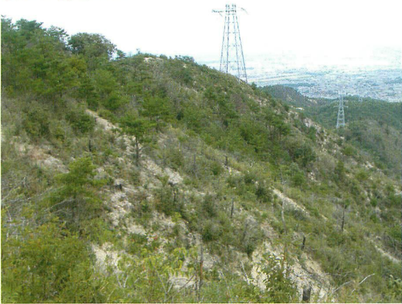
写真5. 尾根部の状況
