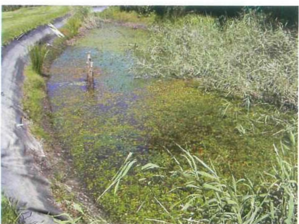
写真3 池No.16 土手をシートで補強 2002年8月30日
