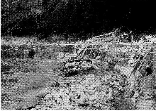
写真2 生野町・市川(1978.1) 調査水域の護岸工事状況
