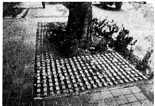
写真2 ネピアロード緑道でのエアレーションの例
